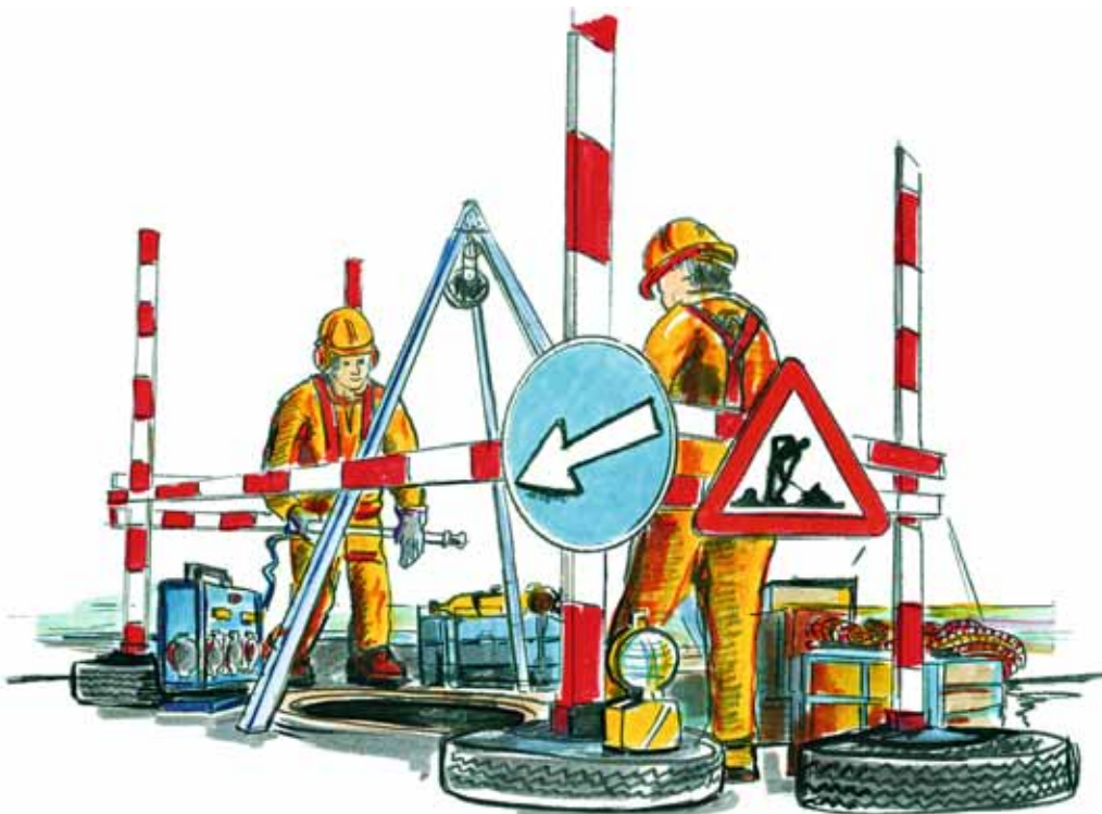
Figura 4: sbarramento e segnalazione della zona di lavoro.
