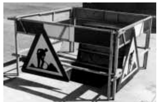
Figura 10: Sbarramento di uno scavo.
