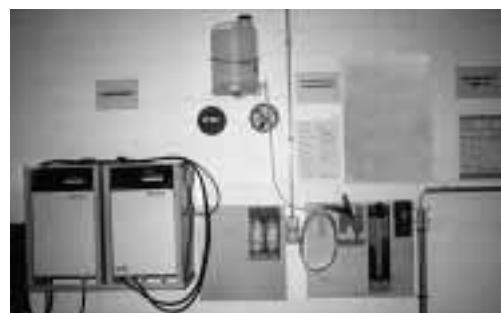
Figura 4: stazione di carica batterie adeguatamente equipaggiata con divieto di fumare. Sono a disposizione gli occhiali di protezione e il lavaocchi.
