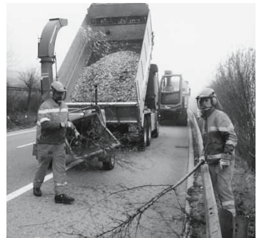
Fig. 4: la bocca di scarico è rivolta verso il camion, in modo da non rappresentare un pericolo per le persone.
