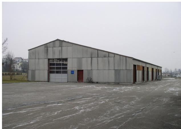
1 Capannone industriale rivestito di lastre ondulate in fibrocemento
