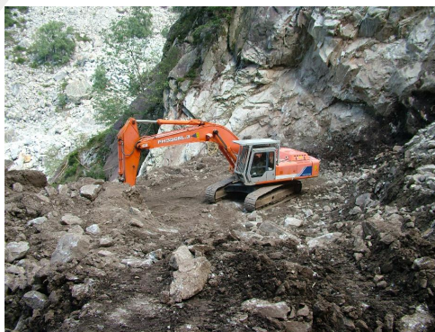
Fig.1: Preparazione e manutenzione sito di cava
