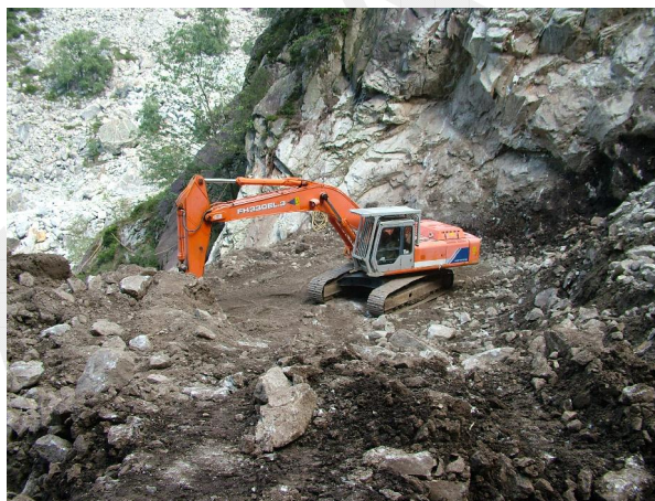
Fig.1: Preparazione e manutenzione sito di cava
