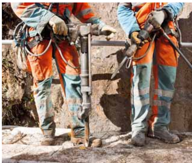
Foto 8 Non impiegare apparecchi troppo potenti. Esempio: evitare di usare un martello demolitore per lavori di scalpellatura semplici.
