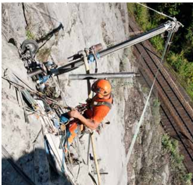
Foto 9 I dispositivi di fissaggio attenuano le vibrazioni emesse dalle macchine portatili.
