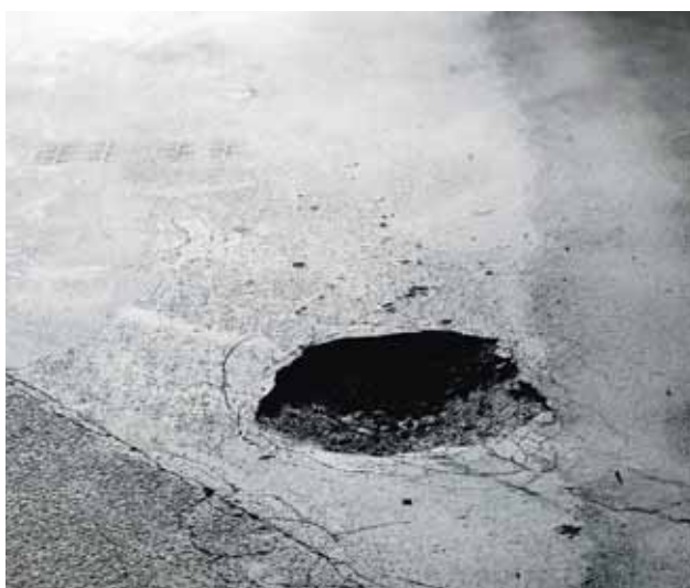
Foto 20 Solchi, buchi o dossi sul terreno provocano elevate vibrazioni per i conducenti.
