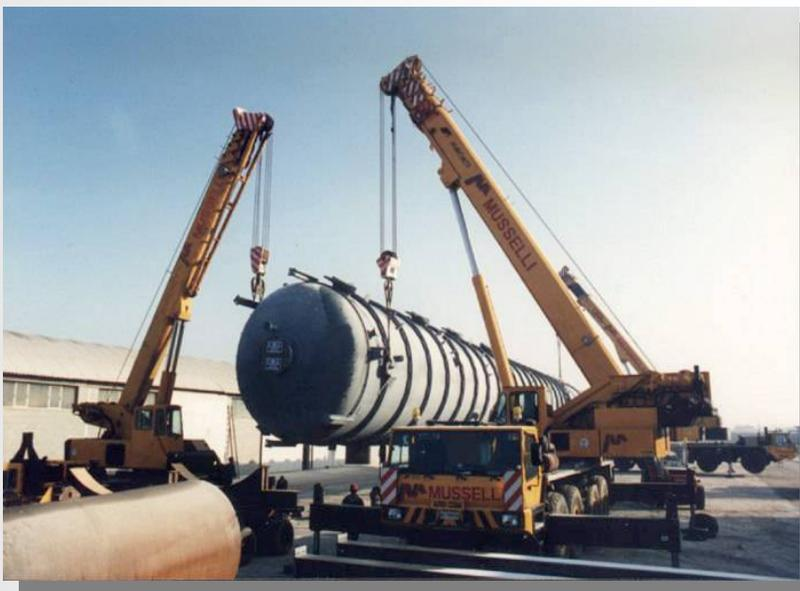
*Scegliere il sistema di aggancio, controllare l'imbracatura e il corretto bilanciamento del carico. Impiegare adeguate protezioni per impedire abrasioni, tagli, stiramenti alle imbracature e agli accessori di sollevamento*
