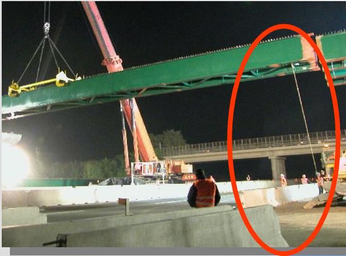
Qualora sia necessario guidare il carico durante la movimentazione, adottare le seguenti misure.
