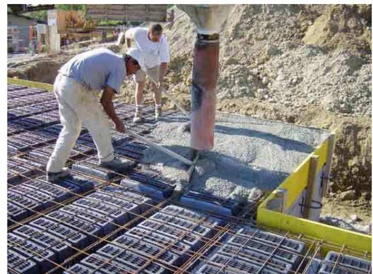
fig. 4 – Blocchi interposti in polipropilene
