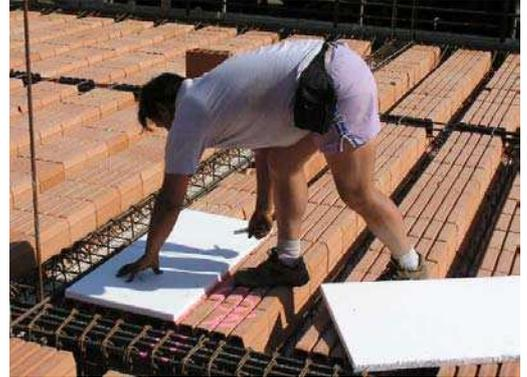
figg. 68 e 69 - predisposizione elementi per forometrie
