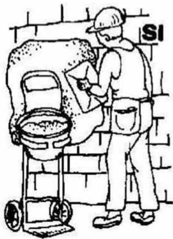
Intonacatura: utilizzare appositi supporti in modo da alzare il punto di presa della malta
