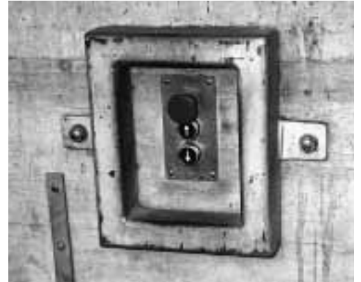
Figura 7: unità di controllo con pulsante di arresto di emergenza e protezione antiurto.
