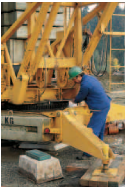
Figura 22 Basta sapere come! Una buona preparazione dei lavori permette di procedere senza problemi.
