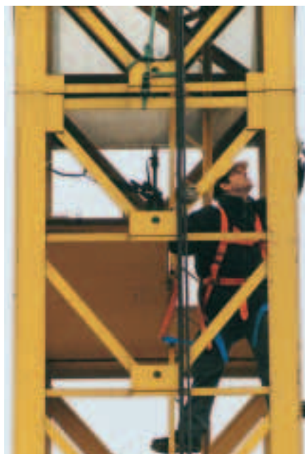
Figura 16 Durante il lavoro quotidiano si provvede anche a ispezionare i collegamenti bullonati.
