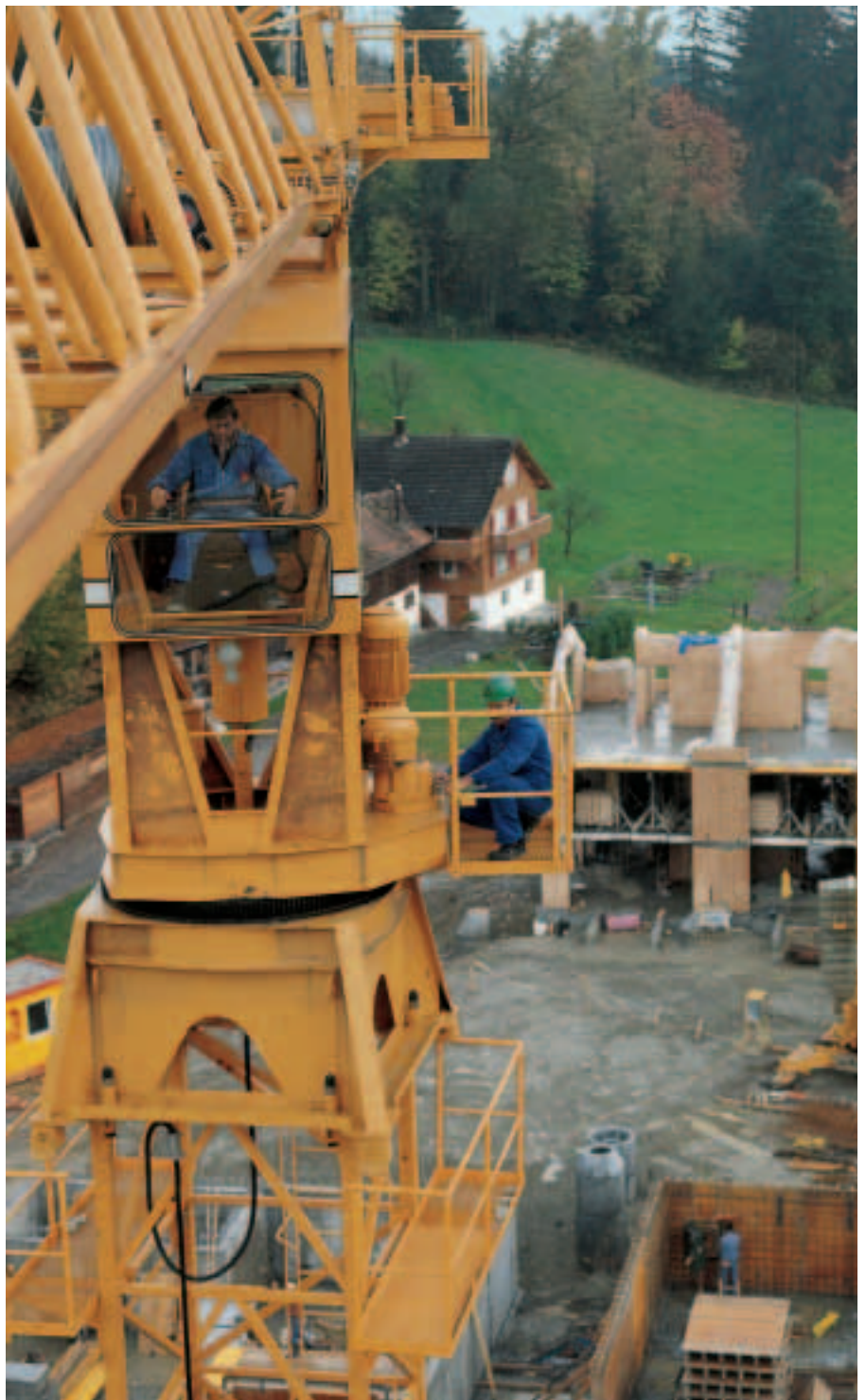
Figura 24 Montaggio di bulloni da un posto di lavoro sicuro.
