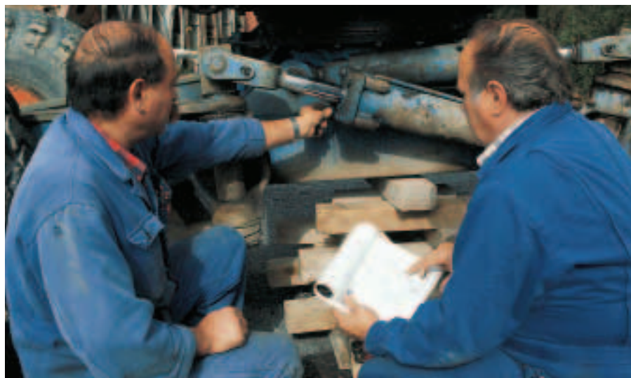
Figura 21 Preparazione dei lavori: capo cantiere e montatore in colloquio.
