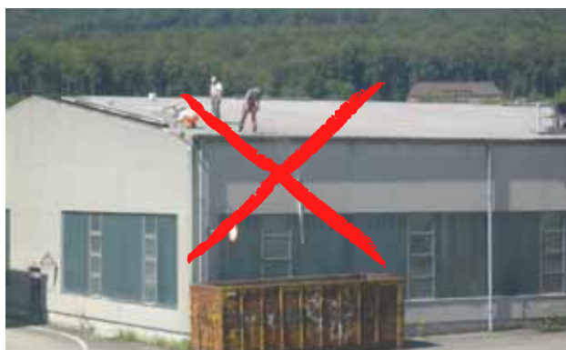
1 e 2 Comportamento gravemente negligente durante i lavori su coperture in fibrocemento e in prossimità di pannelli traslucidi.
