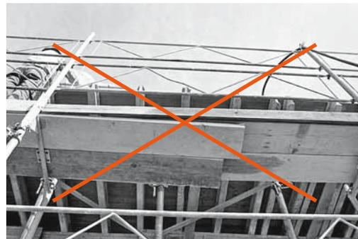
Fig. 3: le tavole posate a sbalzo sono particolarmente pericolose perché è impossibile individuarle dall'alto.
