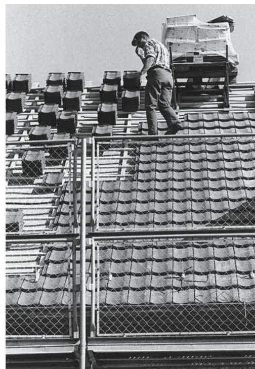
Fig. 6: sui tetti inclinati la parete di protezione in tralfo metallico per copritetti offre una protezione ideale contro la caduta di persone, oggetti e materiale.
