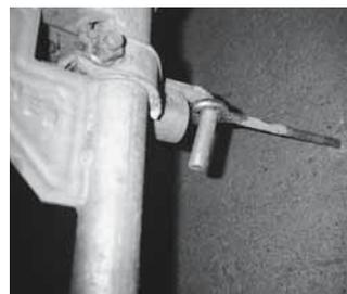
Fig. 2: ancoraggio resistente a trazione e compressione costituito da bussola e vite ad anello di portata sufficiente.
