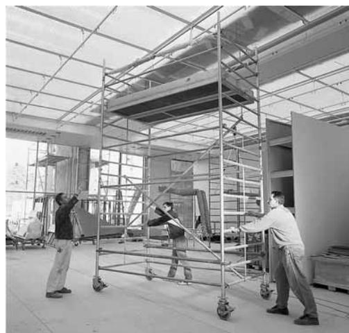
Figura 5: il ponteggio può essere spostato solo dopo che tutti i lavoratori sono scesi.
