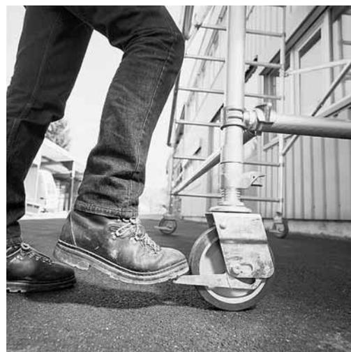
Figura 4: per evitare lo scivolamento del ponteggio bisogna bloccare le ruote.
