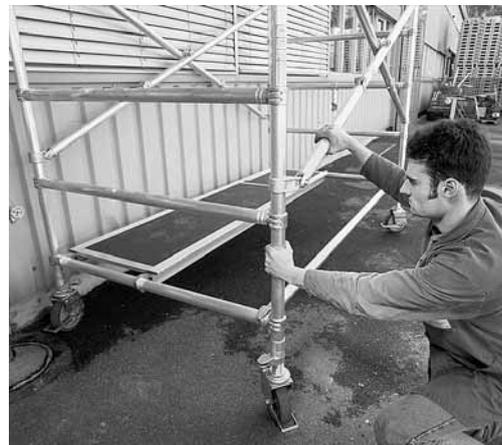
Figura 1: un ponteggio mobile su ruote in perfette condizioni è la premessa fondamentale per lavorare in condizioni di sicurezza.
