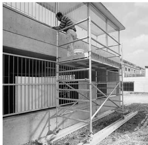
Figura 2: un piano di appoggio solido impedisce il cedimento delle ruote.
