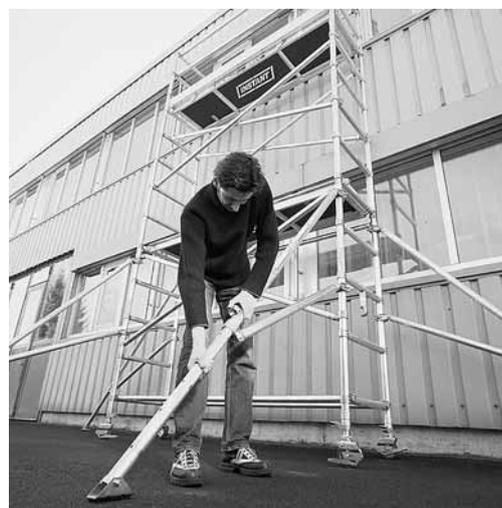
Figura 3: nella guida di installazione è indicato a quale altezza bisogna montare gli stabilizzatori.
